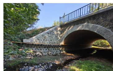
Le passage à loutres, fixé le long de la paroi, offre un cheminement hors de l'eau sous l'ouvrage. Photo Guillaume Sevelinge
